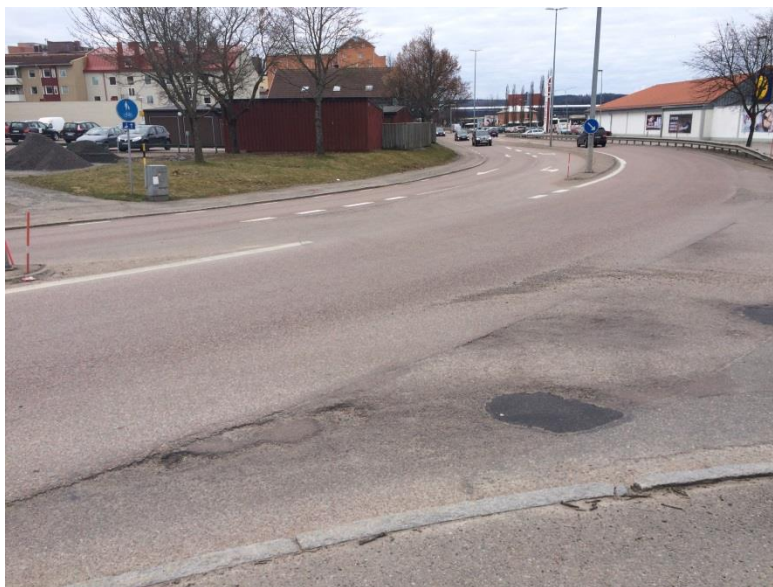
Korsning Kajvägen – Bergslagsgatan där ny cirkulationsplats ska anläggas
